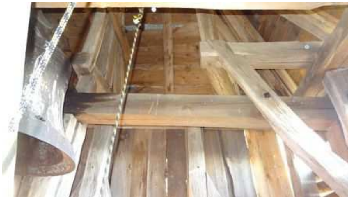
Zdj. nr 24 Widok ściany wschodniej. Widoczna belka usztywniająca konstrukcję wieży w kierunku północ - południe. Widoczne deskowanie pionowe elewacji nadaje się do wymiany.
