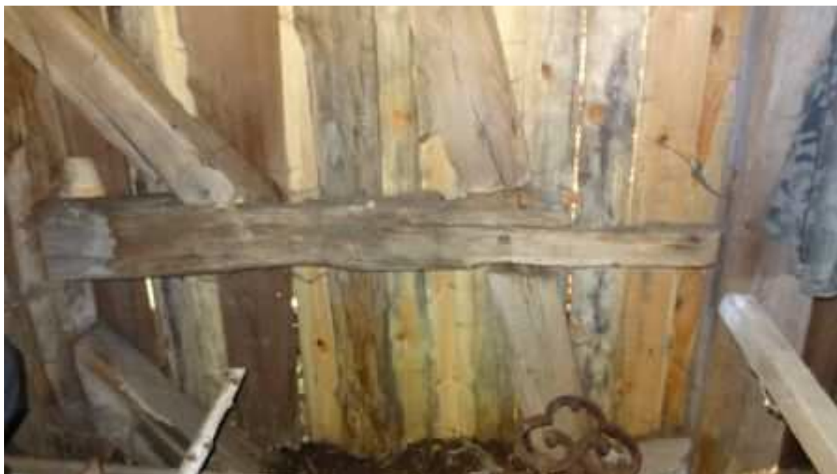
Zdj. nr 14 Widok ściany wschodniej. Liczne prześwity deskowania, braki konstrukcji widoczne na zastrzałach i ryglach.
