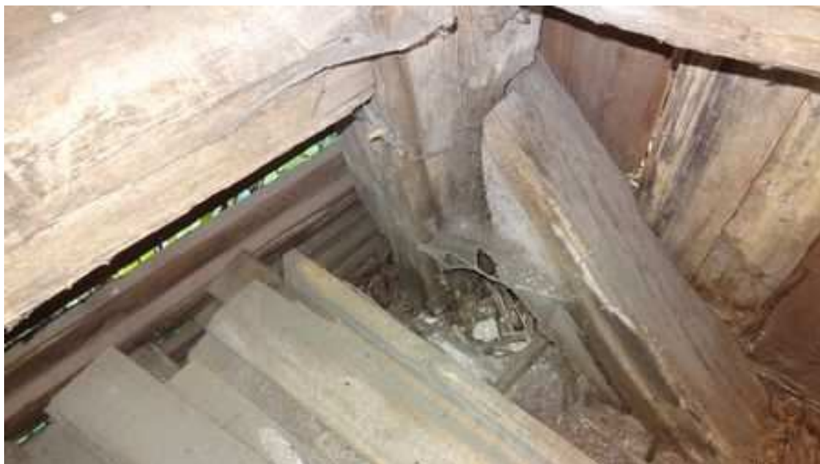
Zdj. nr 12 Widok narożnika północno-wschodniego. Całkowita destrukcja podwaliny. Zagrzybione deski poszycia wieży. Wysoki poziom gruntu od zewnątrz powoduje zamakanie podwaliny i desek.
