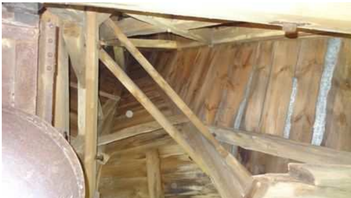
Zdj. nr 32 Widok południowo - zachodniego fragmentu więźby dachowej. Na deskowaniu widoczne zacieki. Deskowanie pod blacharką wykonano ze sporymi przerwami.
