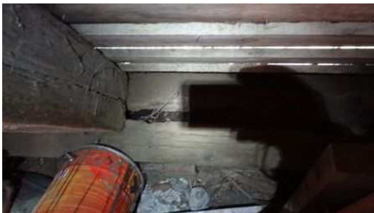
Zdj. nr 6 Widok podwaliny zachodniej. Podwaliny zagłębione są częściowo poniżej poziomu gruntu i w wyniku zawilgocenia uległy korozji biologicznej.
