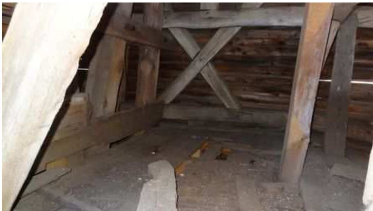
Zdj. nr 28 Widok ściany północnej na poziomie I piętra. Stan konstrukcji niezadowalający z niewielkimi uszkodzeniami. Deskowanie elewacji i deski stropu do wymiany.
