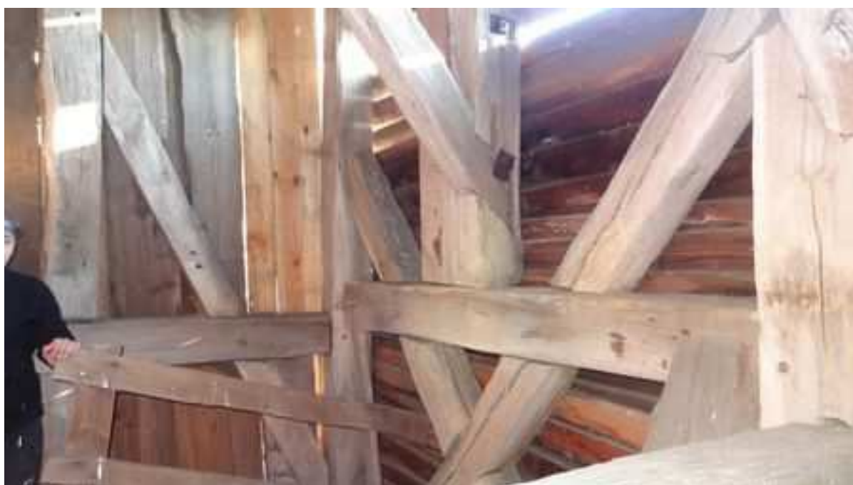
Zdj. nr 24 Widok ściany wschodniej. Widoczna belka usztywniająca konstrukcję wieży w kierunku północ - południe. Widoczne deskowanie pionowe elewacji nadaje się do wymiany.
