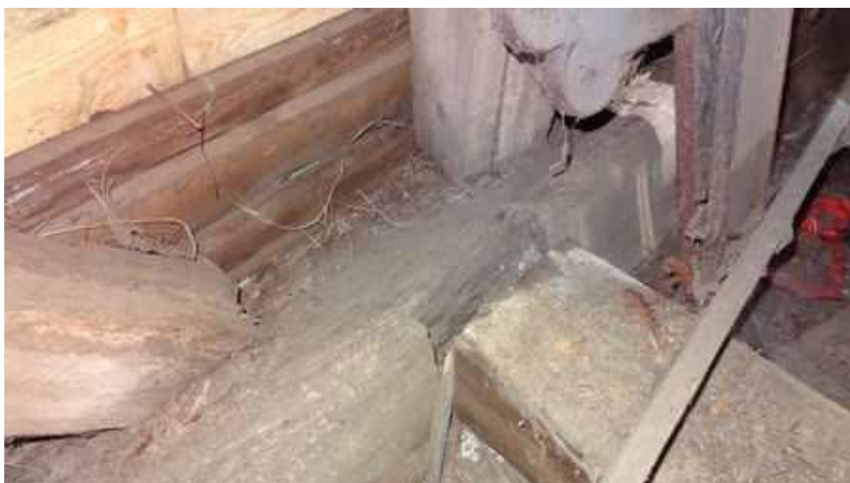
Zdj. nr 8 Widok ściany zachodniej. Zastrzał na skutek odkształcenia wieży został wysunięty o ok. 5 cm z gniazda.
