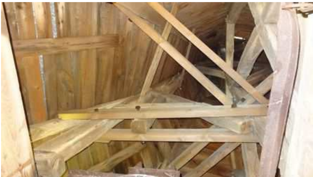
Zdj. nr 36 Północna część więźby dachowej znajduje się w dobrym stanie. Widoczne dodatkowe jętki usztywniające więźbę.
