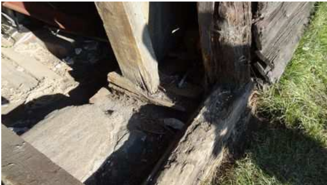
Zdj. nr 5 Widok mocno uszkodzonej podwaliny (progu drzwiowego) w narożniku południowo- zachodnim. Końcówki słupów podobnie jak podwalina uległy korozji biologicznej na skutek zawilgocenia.
