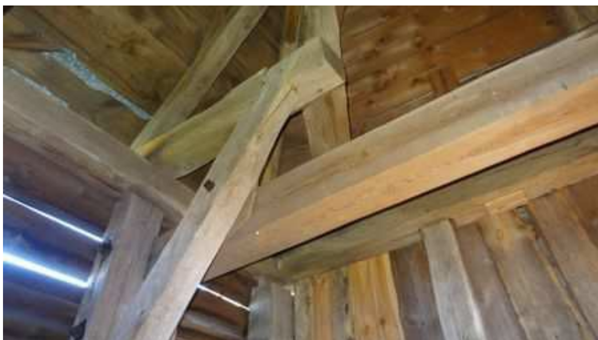
Zdj. nr 36 Północna część więźby dachowej znajduje się w dobrym stanie. Widoczne dodatkowe jętki usztywniające więźbę.
