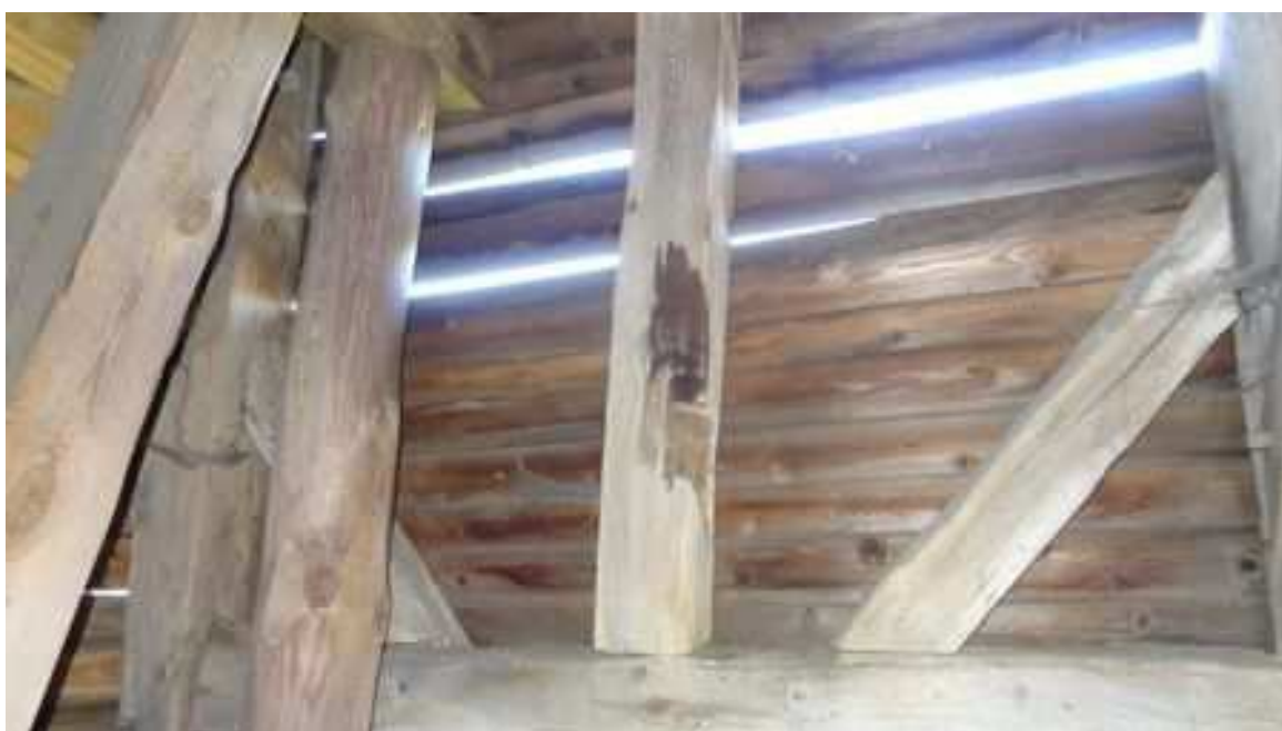
Zdj. nr 21 Narożnik północno-zachodni I piętra. Widok słupa wieży uszkodzonego mechanicznie i porażonego grzybem budowlanym - element do ociosania.
