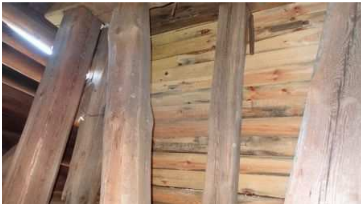
Zdj. nr 18 Widok narożnika południowo-zachodniego I p. Widoczna dodatkowa konstrukcja wsporcza usztywniająca wieżę w kierunku północ - południe. Stan wtórnej konstrukcji jest dobry.
