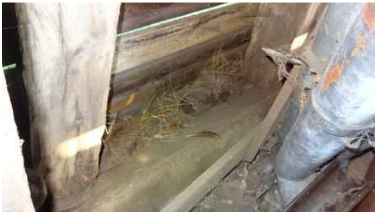
Zdj. nr 10 Widok podwaliny północnej przy słupie środkowym. Podwalina na skutek uszkodzenia przez grzyby budowlane przekreśliła się na zewnątrz. Końcówki słupów są porażone grzybem budowlanym.
