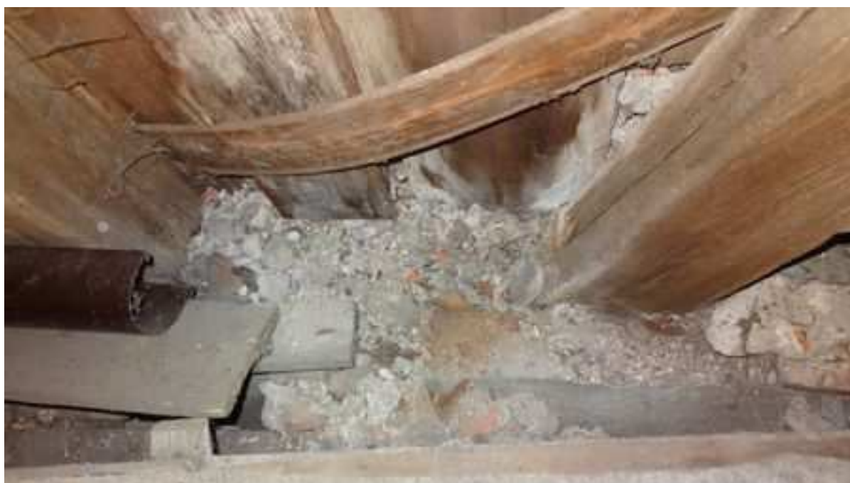
Zdj. nr 15 Widok ściany wschodniej. Podwalina zasypana gruzem. Przechylona na zewnątrz. Deski elewacyjne zagrzybione.
