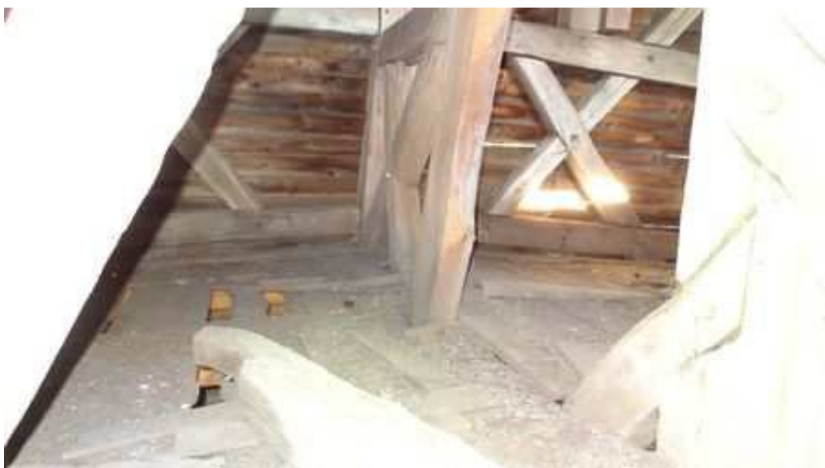
Zdj. nr 29 Widok ściany północnej. Wyraźne przełamanie stropu po stronie wschodniej i zachodniej. Deski stropowe do wymiany.
