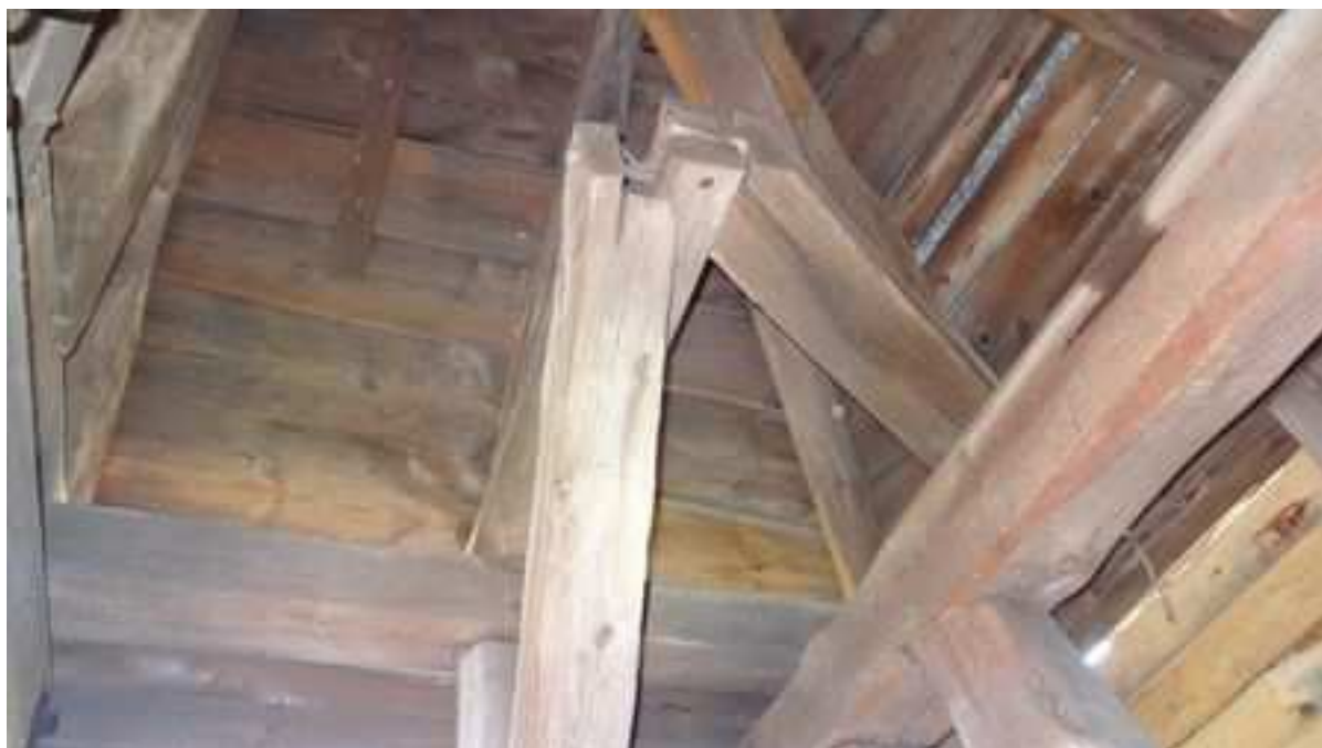
Zdj. nr 38 Widok narożnika południowo - wschodniego więźby. Miecz wysunięty z gniazda. Deskowanie zawilgocone na południowej połaci dachu.
