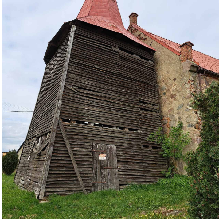
Zdj. nr 4 Widok zachodniej ściany szczytowej kościoła, na której oparła się wieża. Wieża jest wyraźnie pochylona w kierunku wschodnim. Wynika to ze stanu w jakim znajdują się drewniane elementy konstrukcji wieży w strefie przyziemia.
