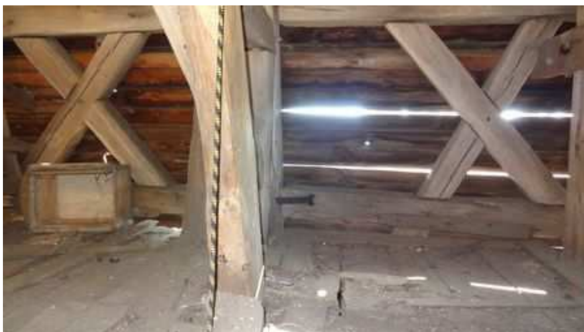
Zdj. nr 26 Konstrukcja podtrzymująca dzwony została wtórnie wzmocnioną jętkami biegnącymi w kierunku północ - południe.
