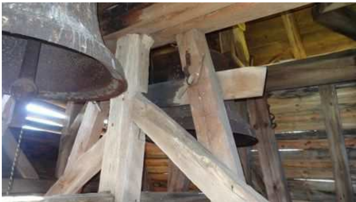
Zdj. nr 26 Konstrukcja podtrzymująca dzwony została wtórnie wzmocnioną jętkami biegnącymi w kierunku północ - południe.
