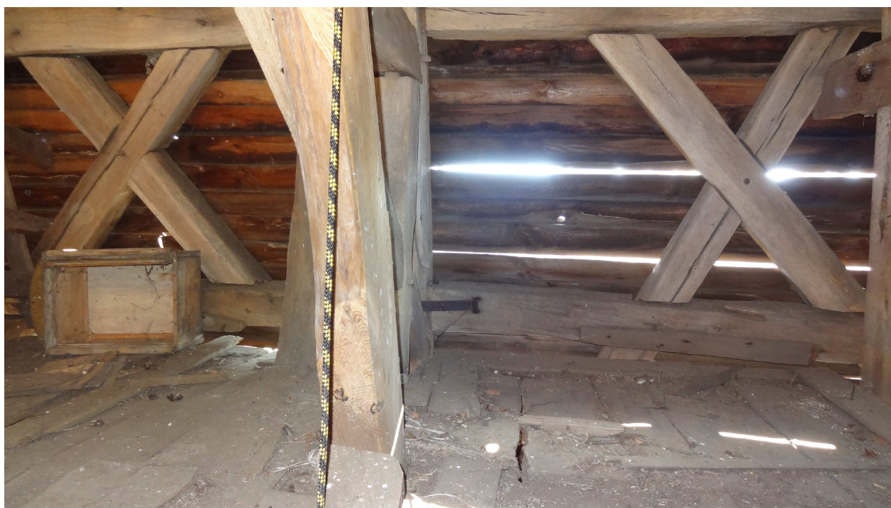
Zdj. nr 19 Widok desek stropu I piętra. Deski uszkodzone o niskiej wytrzymałości, niekompletne należy je wymienić.
