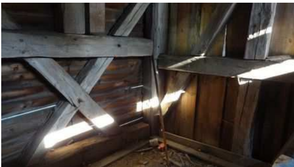
Zdj. nr 22 Widok wzmocnienia w postaci 2 jętek zamontowanych między słupami środkowymi w kierunku wschód - zachód. Miecz zagrzebiony w połowie swojej długości.
