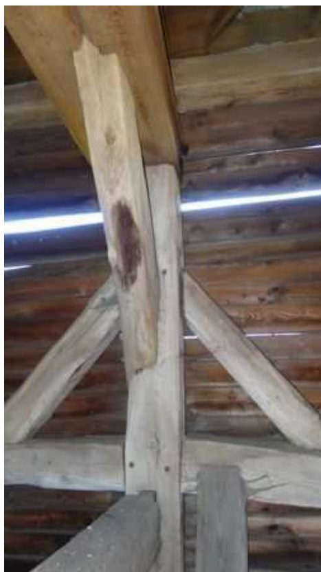
Zdj. nr 22 Widok wzmocnienia w postaci 2 jętek zamontowanych między słupami środkowymi w kierunku wschód - zachód. Miecz zagrzebiony w połowie swojej długości.
