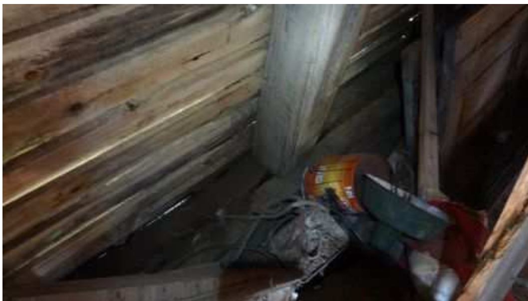
Zdj. nr 6 Widok podwaliny zachodniej. Podwaliny zagłębione są częściowo poniżej poziomu gruntu i w wyniku zawilgocenia uległy korozji biologicznej.
