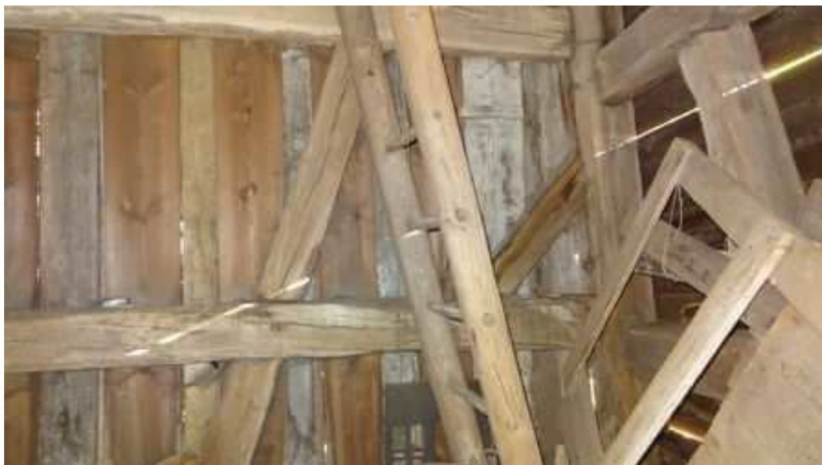
Zdj. nr 16 Widok rygla pierwszego poziomu i zastrzałów na ścianie wschodniej.
