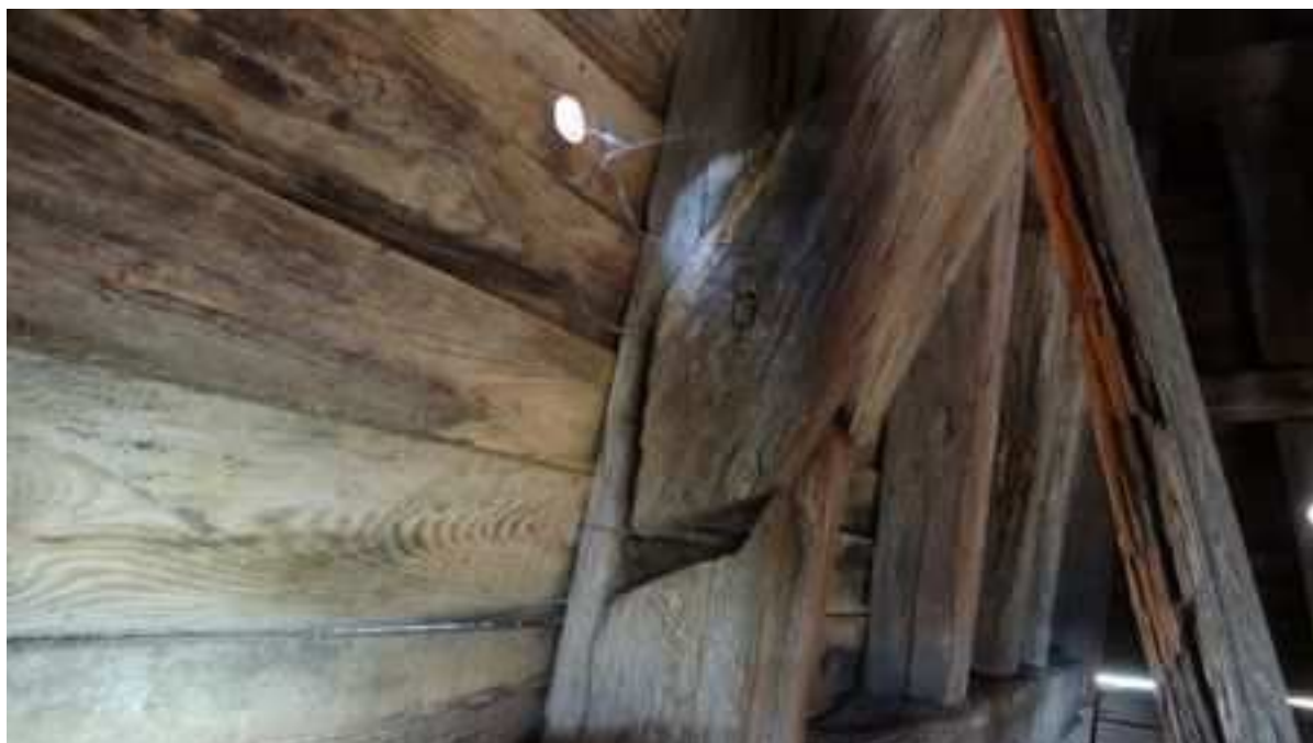
Zdj. nr 8 Widok ściany zachodniej. Zastrzał na skutek odkształcenia wieży został wysunięty o ok. 5 cm z gniazda.
