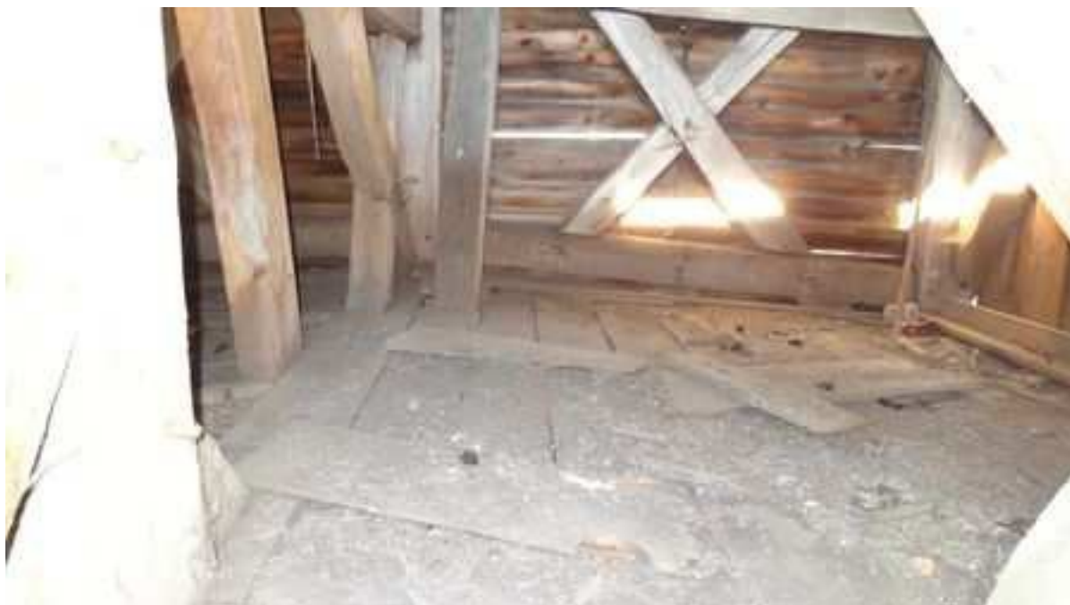
Zdj. nr 30 Widok ściany północnej. Wyraźne przełamanie stropu po stronie wschodniej.
