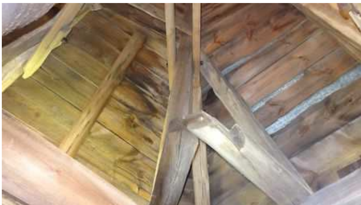
Zdj. nr 35 Widok południowo - zachodniego fragmentu wieźby dachowej. Na deskowaniu widoczne zacieki.
