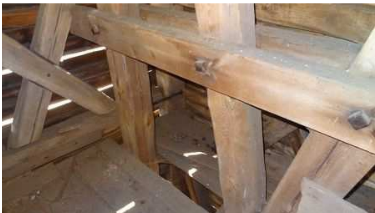
Zdj. nr 17 Widok narożnika południowo-zachodniego I p. Widoczna dodatkowa konstrukcja wsporcza usztywniająca wieżę w kierunku północ - południe. Stan wtórnej konstrukcji jest dobry.
