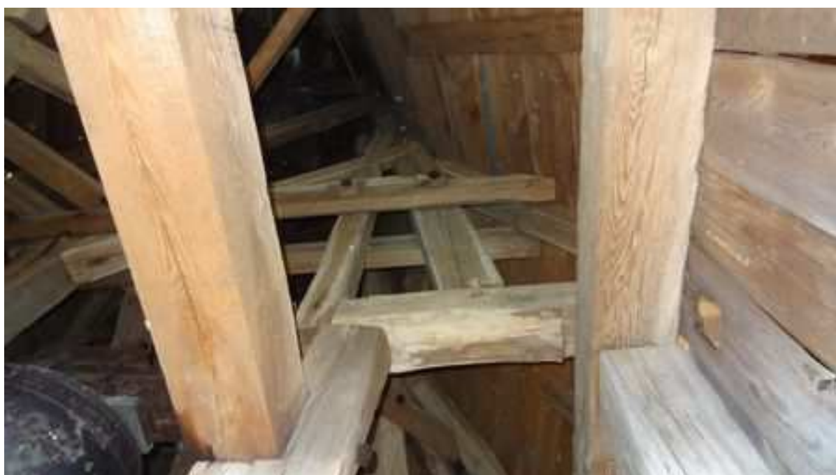
Zdj. nr 32 Widok południowo - zachodniego fragmentu więźby dachowej. Na deskowaniu widoczne zacieki. Deskowanie pod blacharką wykonano ze sporymi przerwami.
