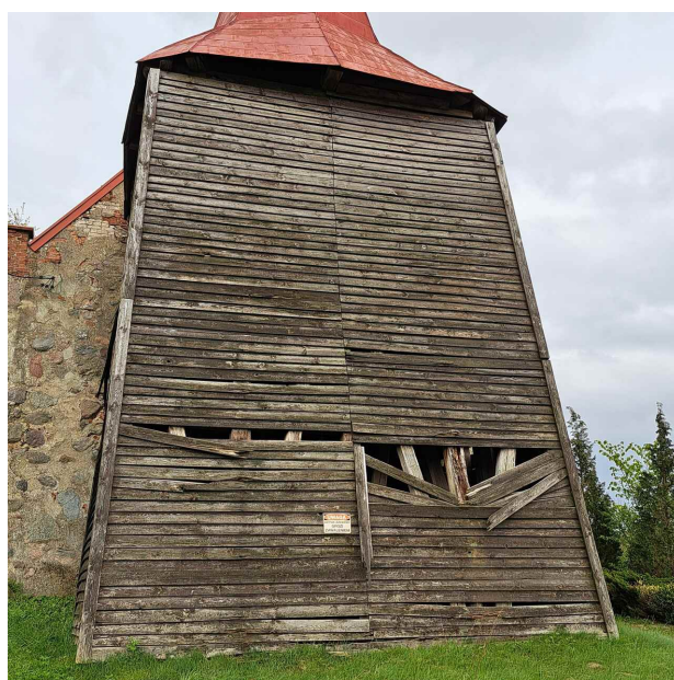
Zdj. nr 2 Widok elewacji zachodniej. Trawnik w pobliżu wieży rośnie na nasypie. Powoduje to zawilgocenie dolnych elementów konstrukcji drewnianej wieży.
