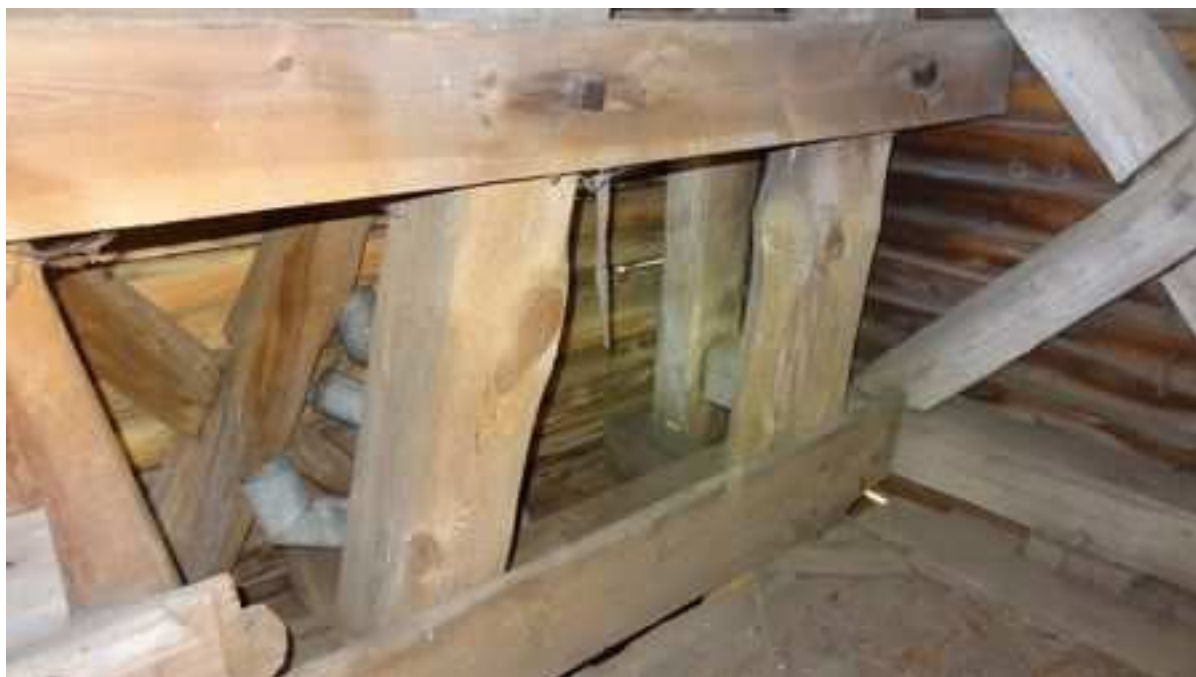
Zdj. nr 20 Widok narożnika północno-zachodniego I p. Widoczna dodatkowa konstrukcja wsporcza usztywniająca wieżę w kierunku północ - południe. Stan wtórnej konstrukcji jest dobry.
