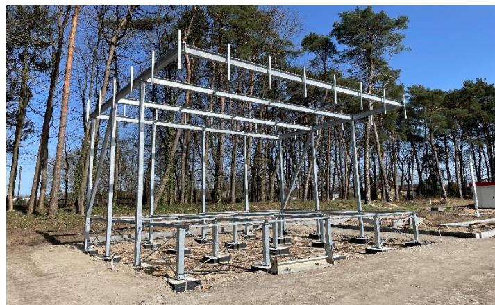
Modernizacja i przebudowa stadionu miejskiego w Chociwlu wraz z zapleczem socjalnym
