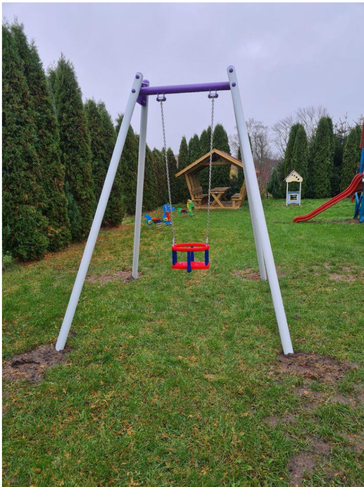
Przebudowa placu zabaw w Kamiennym Moście
