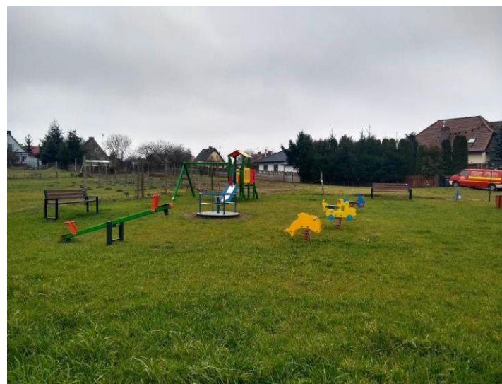
Budowa placu zabaw na działce 414/9 w Chociwlu
