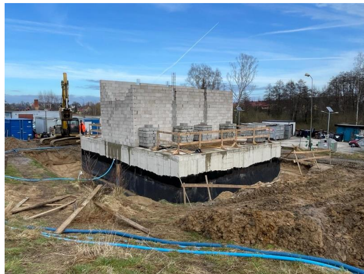
Przebudowa oczyszczalni ścieków w Chociwlu
