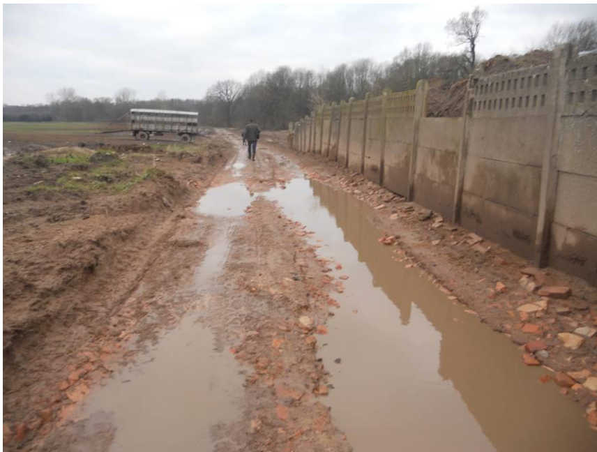
Cegła z rozebranego budynku nr 9. Za ogrodzeniem po prawej, przyzma kisionki nr 2.
