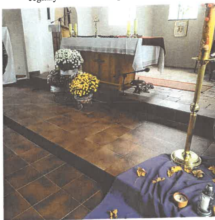
Fot.6. Prezbiterium – współczesna posadzka terakotowa. W części za posoborowym stołem ołtarzowym historyczna z kwadratowych płytek ceramicznych.
