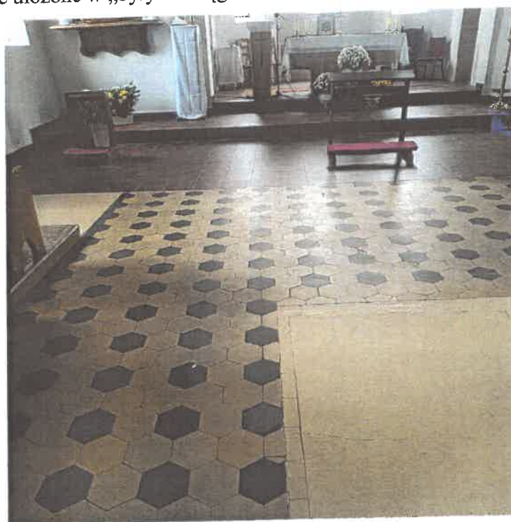
Fot.4. Posadzka nawy – wtórna wylewka cementowa pomalowana farbą olejną i płytki heksagonalne. W tle część prezbiterialna z współczesnymi płytkami terakotowymi i ceglanyymi za ołtarzem posoborowym.
