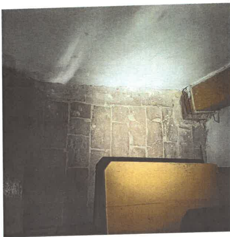
Fot.7. Historyczna posadzka ceglana znajdująca się w kącie pod emporą.
