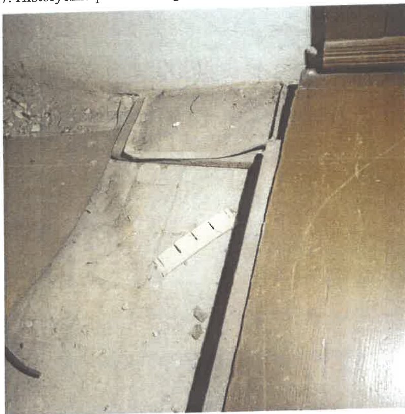
Fot.8. Historyczna posadzka ceglana pod emporą – przykryta płytą dyktową.
