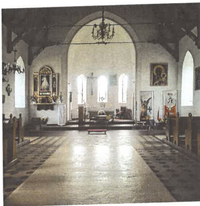
Fot.5. Posadzka nawy – wtórna wylewka cementowa pomalowana farbą olejną i płytki heksagonalne. W tle część prezbiterialna z współczesnymi płytkami terakotowymi i ceglanymi za ołtarzem posoborowym.
