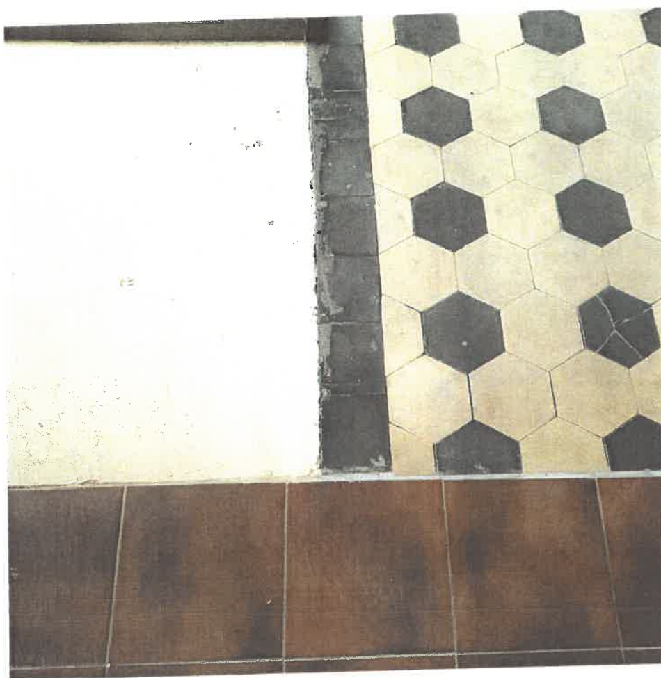
Fot.11. Widok z bliska na mnogość posadzek znajdujących się w jednym obiekcie (powodują chaos stylistyczny). Z lewej: wylewka cementowa pomalowana kilkukrotnie pożółkłą farbą olejną (w miejscu, gdzie pierwotnie stały ławki). Z prawej: czarno – białe spękane płytki kamionkowe w miejscach byłych ciągów komunikacyjnych w nawie. U dołu współczesne płytki terakotowe.
